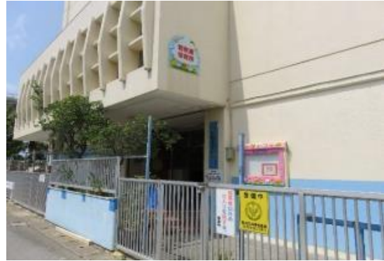
若狭市堂住宅六号棟の一階が若狭浦保育所です
