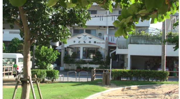
◎ 緑の環境と充実した設備。まもなく工事を終え(写真は旧園舎)で、令和元年9月に新設認可園としてオープン予定！
